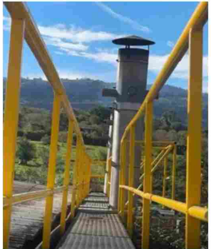
Foto. Plataformas e instalación de niples en chimeneas del secadero de café La Plata Cruce Fuente: Banco de imágenes Cadefihuila
